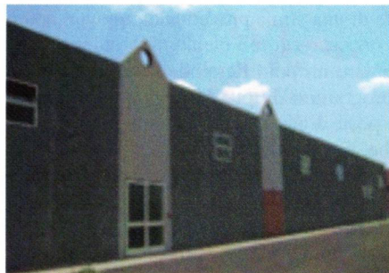
Facciata principale opificio con celle
